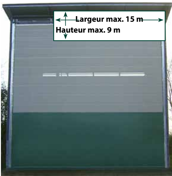
Porte sectionnelle, largeur 13 m, hauteur 8 m
