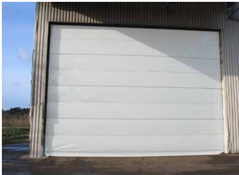
Porte sectionnelle, largeur 12 m, hauteur 8 m
