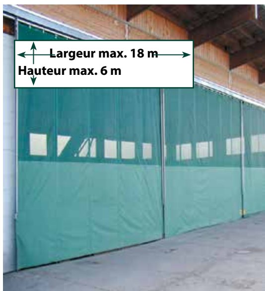
Porte coulissante d'un bâtiment pour machines
