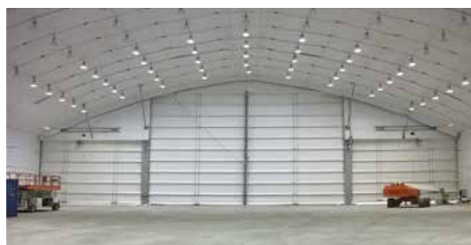
Bâtiment de maintenance avec membrane interne
