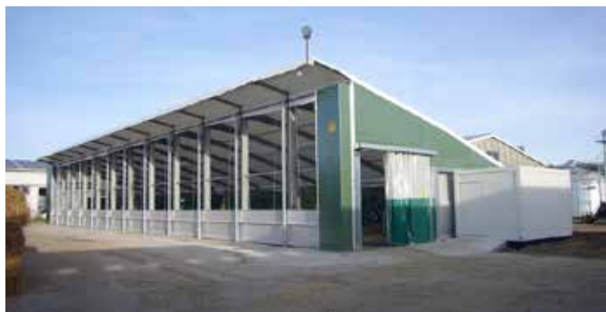
Toit en appentis
