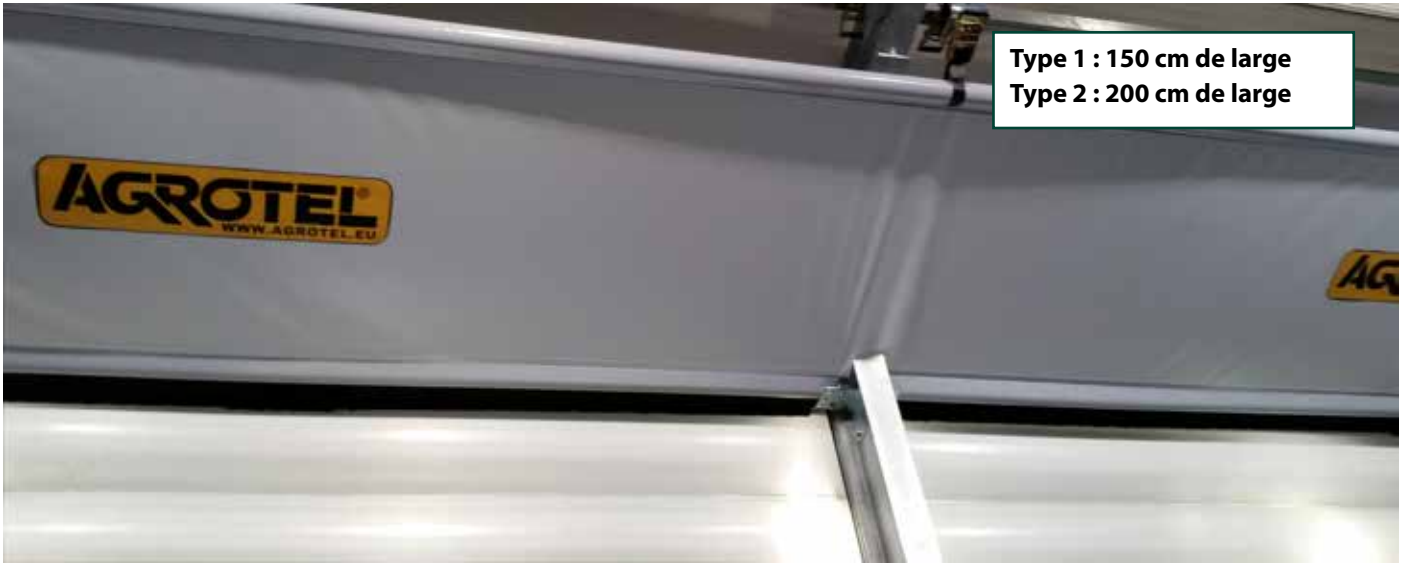
La bâche de guidage d'entrée d'air AGROTEL vue de l'intérieur, par le dessous
