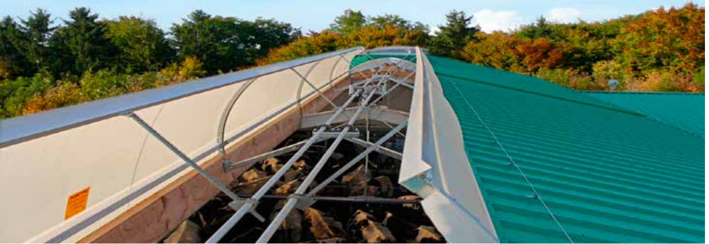
Faîtage avec deux arbres d'entraînement, ouvert des deux côtés
