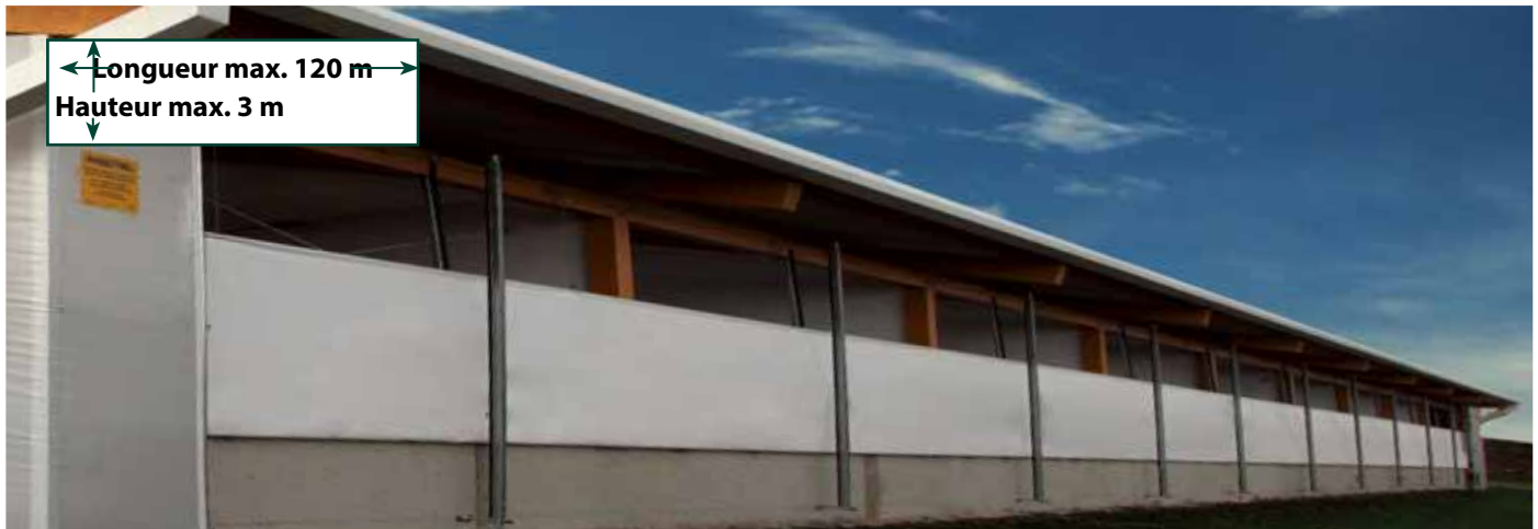
Ouverture de la paroi se rétractant vers le bas
