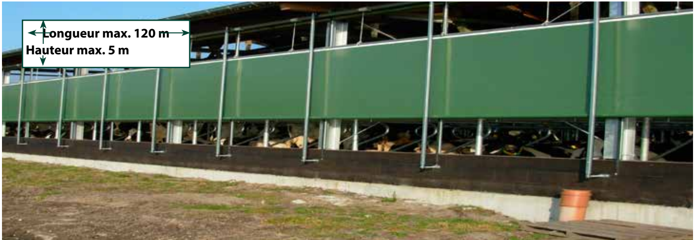
Technique de paroi à enroulement en position ombragée
